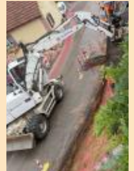
Recouvrement des réseaux.
