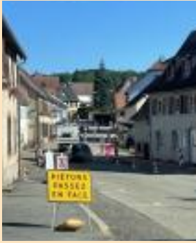
Visulisation du trottoir par une moquette rouge.
